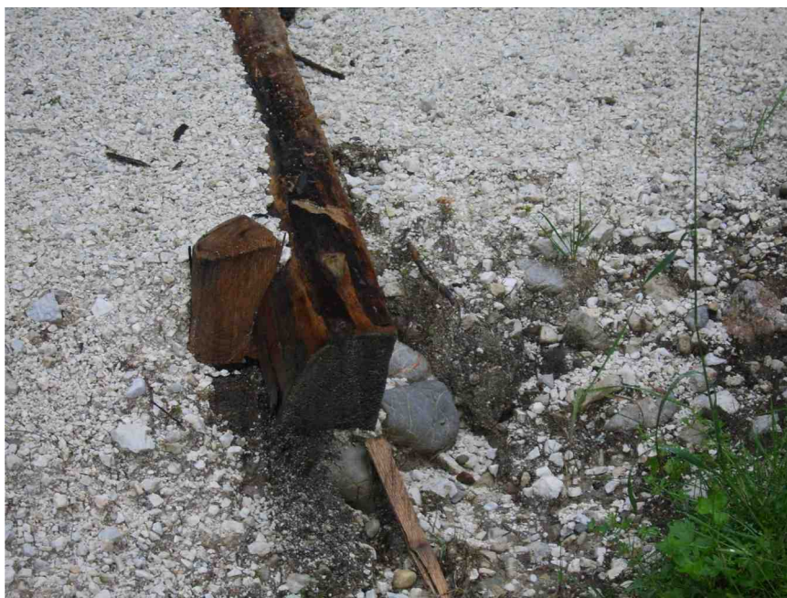
Slika 21: Razpršitev vode – detajl (Lt9)
