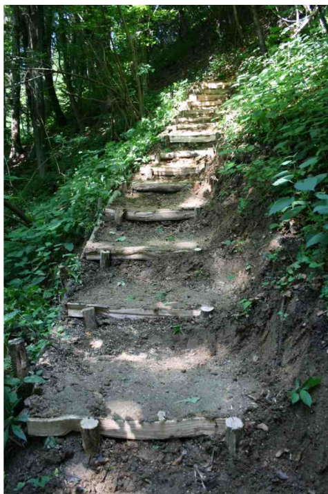
Slika 6: Utrditev načete poti s stopnicami (Lt9)
